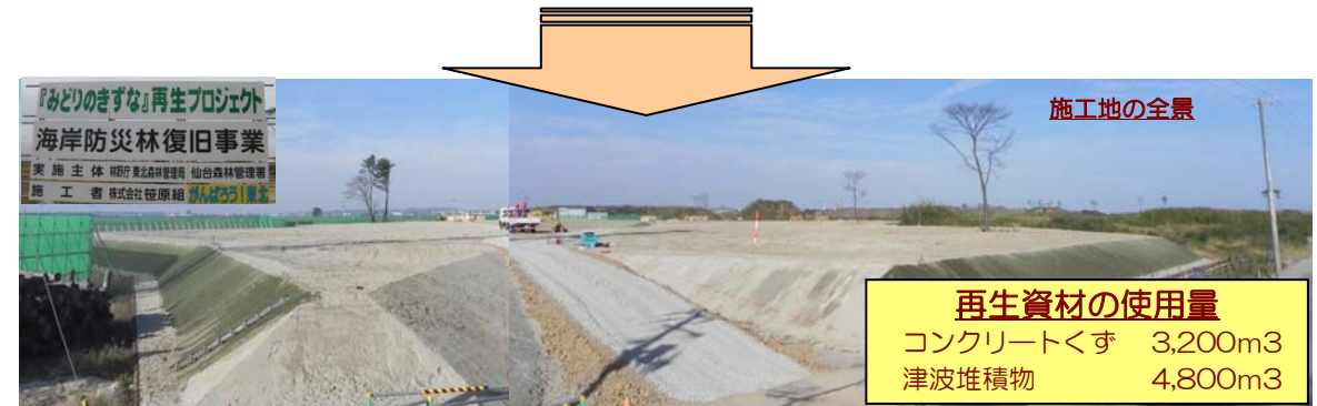
工事用道路への活用（コンクリートくず）
