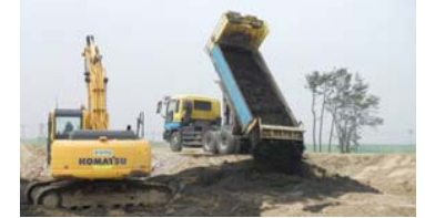
盛土材への活用（津波堆積物）
