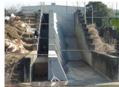
写真-2 高落差実験水路（縮尺1/2）→
