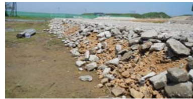
工事用道路への活用（コンクリートくず）
