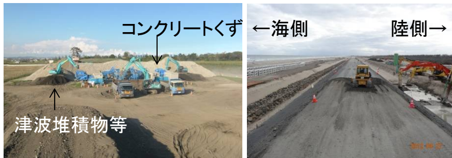
震災瓦礫の混合状況 (仙台市深沼南工区)
